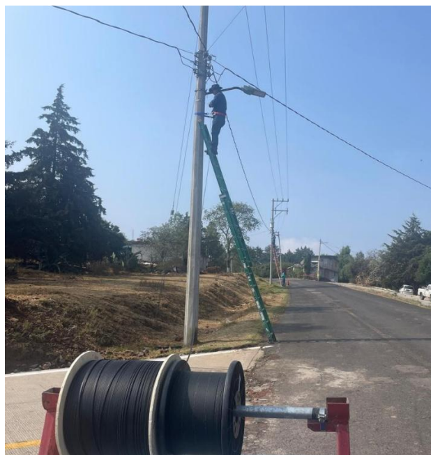
Figura 6.19 Tendido de la red troncal de fibra óptica (elaboración propia).
