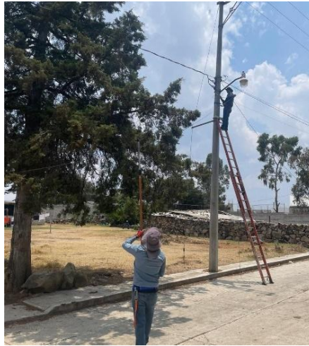
Figura 6.23 Tendido final de la primera derivación (elaboración propia).
