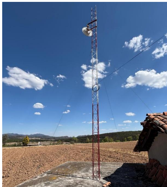
Figura 6.14 Levantamiento de torre e instalación del plato Dish (elaboración propia).
