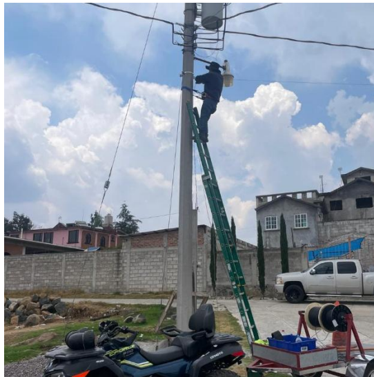
Figura 6.24 Tendido de la segunda derivación o ramal (elaboración propia).
