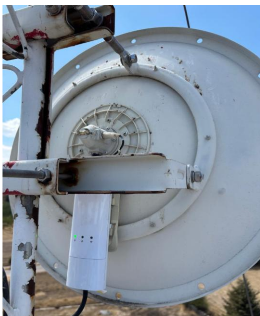
Figura 6.12 Instalación y cableado de la radio Mimosa (elaboración propia).
