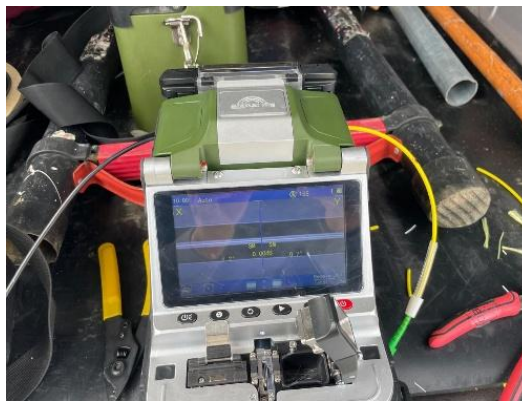
Figura 6.37 Fusión de la fibra Drop con el jumper SC/APC (elaboración propia).
