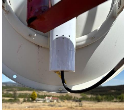
Figura 6.15 Instalación y cableado de la radio Mimosa C5c “Station” (elaboración propia).
