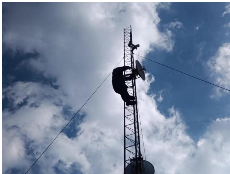
Figura 6.11 Instalación del plato Dish base (elaboración propia).
